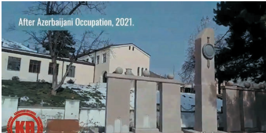
Рис. 6. Разрушенный хачкар села Ухтадзор Гадрутского района.
