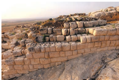
Рис. 3. Верхняя часть северной крепостной стены, 2009 г.
