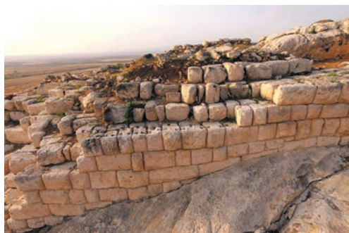
Рис. 3. Верхняя часть северной крепостной стены, 2009 г.
